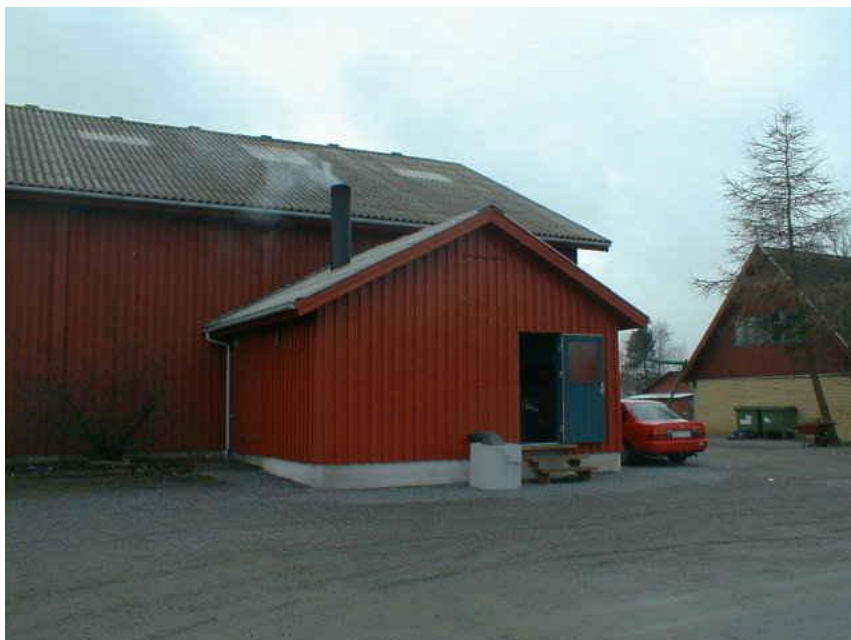
Biobrændselsanlægget på Østerlars Friskole
